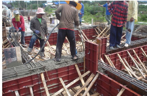
รูปที่ 19 การเทและต้องกระทุ้งให้คอนกรีตด้วยเครื่องสั่น (Vibrator)
