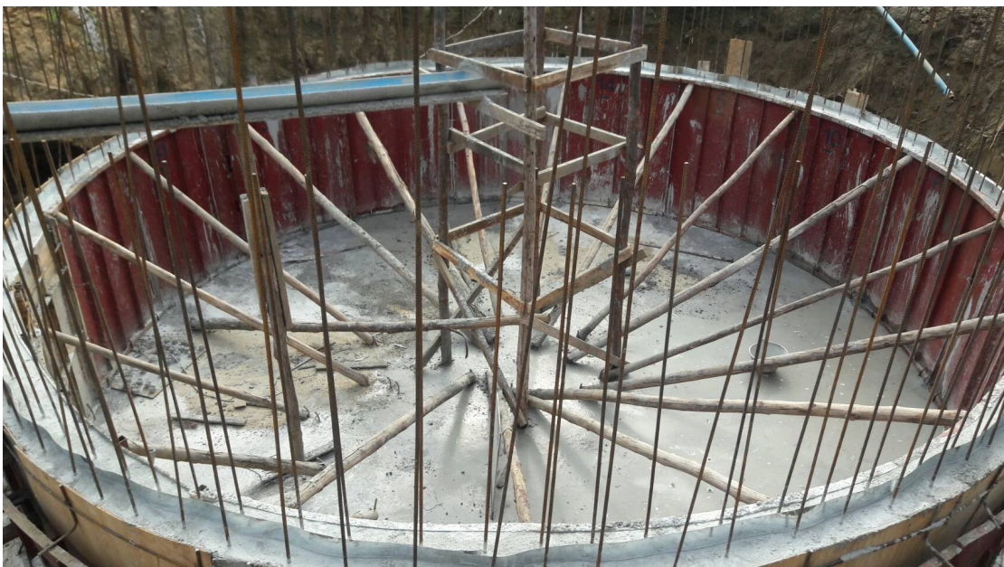
รูปที่ 70 งานเทคอนกรีตผนังถังเก็บน้ำต้องทำการติดตั้งแผ่นสังกะสีกันซึมช่วงรอยต่อคอนกรีต
