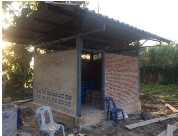
รูปที่ 32 งานก่ออิฐฉาบปูนโรงสูบน้ำ
