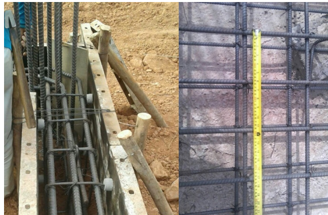
รูปที่ 17 การตรวจสอบเหล็กเสริม ค้ำยัน และการหนุนลูกปุน ก่อนการเทคอนกรีต
