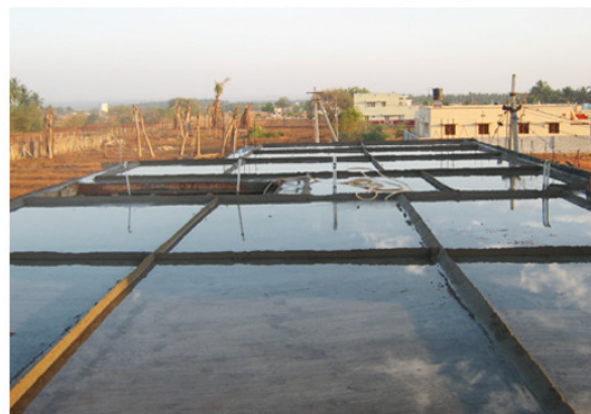
รูปที่ 21 การบ่มคอนกรีตโดยใช้น้ำซัง
